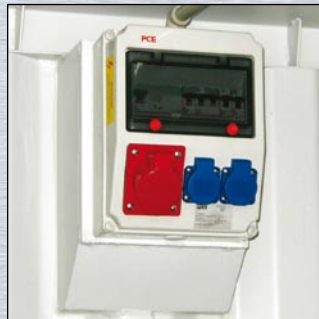
електрическо табло с вграден предпазител
