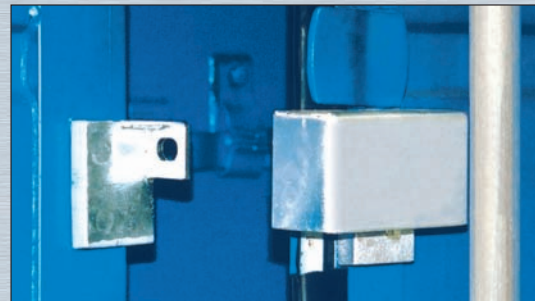
Das Vorhangsicherungsschloss wird abgedeckt.
