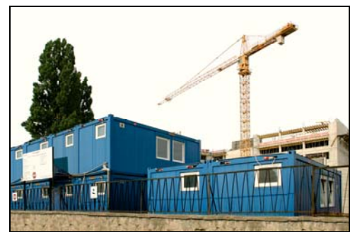
Bürocontainer im Baustelleneinsatz
