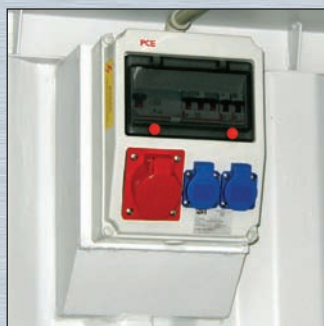
Verteilerkasten mit integrierten Steckdosen
